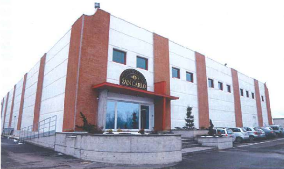
Fig. 1 - Stabilimento Salumificio San Carlo – Ziano Piacentino
